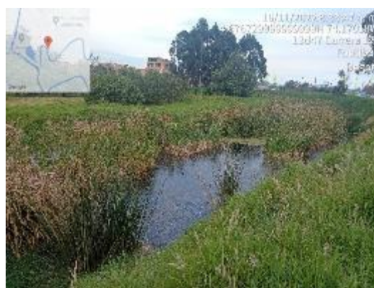
Fotografía 40 Cauce despejado después intervención de AB. Contrato 9-99-24300-1252-2022
