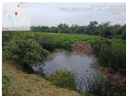
Fotografía 42 Cauce despejado después intervención de AB. Contrato 9-99-24300-1252-2022
