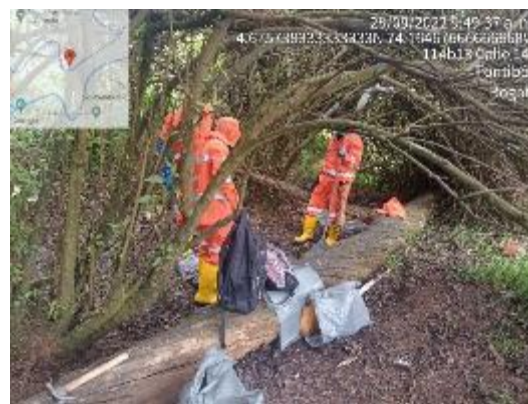
Fotografía 56 Evidencia de retiro de residuos en rivera del Humedal.
