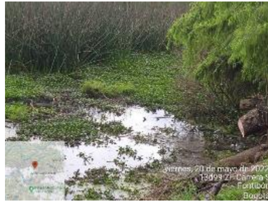
Fotografía 36 Se evidencia que se retiró árbol volcado en cauce. Contrato 9-99-24300-0867-2021.
