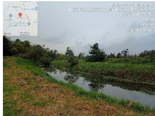
Fotografía 38 Cauce despejado después intervención de AB. Contrato 9-99-24300-0867-2021
