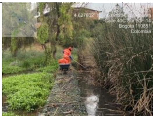
**Fotografía 67.** Mantenimiento al biofiltro y despeje de material vegetal del gavión del sector norte del humedal La Vaca.
