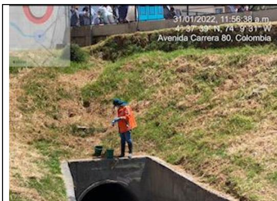
**Fotografía 50.** Monitoreo de calidad de agua en el colector del sector norte del humedal La Vaca, por la EAAB-ESP
