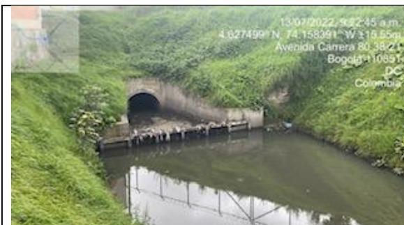
**Fotografía 76.** Presencia de RSO y conexiones erradas, en la entrada de agua colector de agua del humedal del sector norte.
