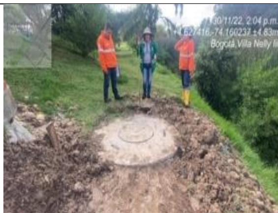
**Fotografía 79.** Arreglo de la socavación del suelo en la coordenada + 4.627416, - 74.160237.
