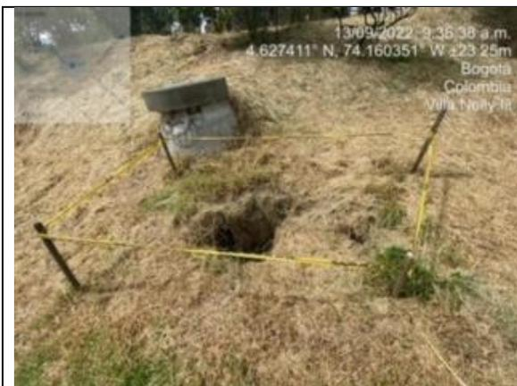
**Fotografía 78.** Socavación del suelo cercano al pozo de inspección en el sector norte del humedal.
