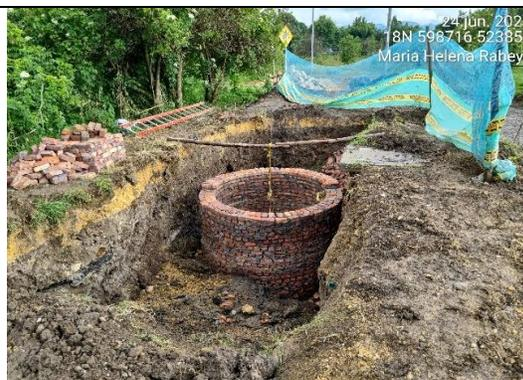
**Fotografía 56** Obra de identificación y corrección conexiones erradas a la altura del Barrio La Gaita Sector de Carabineros
