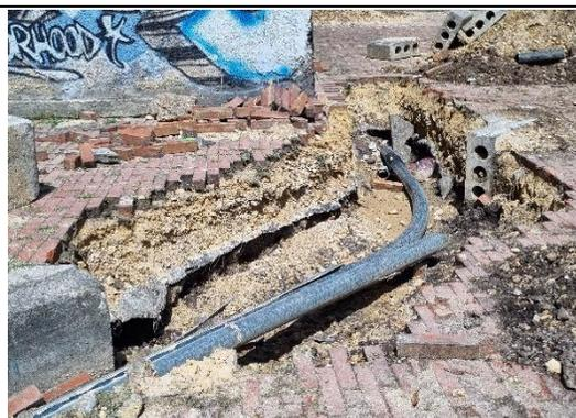
**Fotografía 54** Obra de identificación y corrección conexiones erradas a la altura del Barrio Villa Cristina
