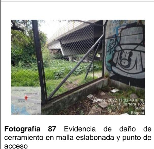
**Fotografía 87** Evidencia de daño de cerramiento en malla eslabonada y punto de acceso
