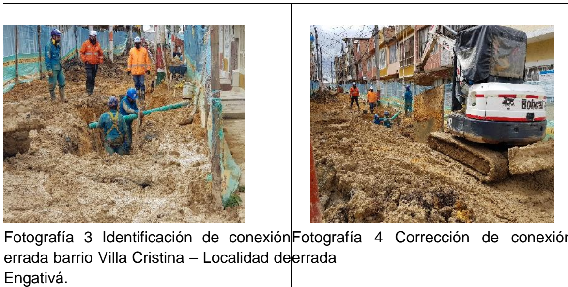
Figura 3. Fotografías 3, Identificación de conexión errada y Fotografía 4, Corrección de conexión errada.
