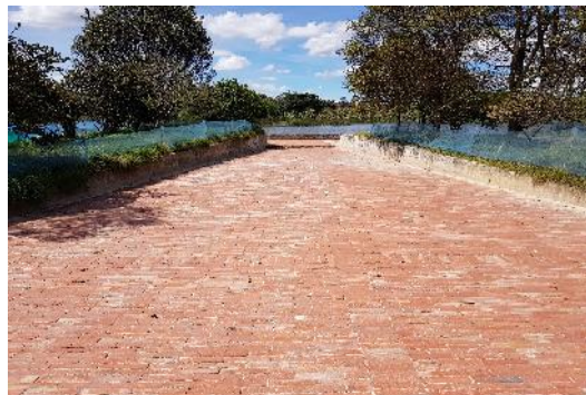
Fotografía 12 Construcción sendero combinado corredor ambiental borde norte – tercio Alto.
