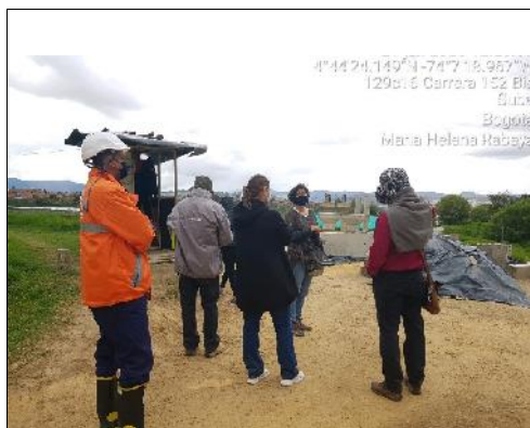
Fotografía 73 Recorrido obras con SCAPS verificación POC y avance de las obras de corredores ambientales.
