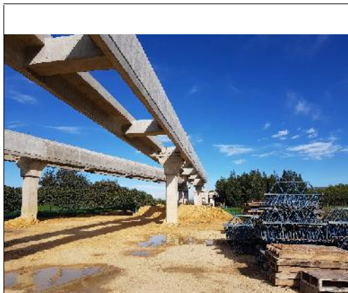
Fotografía 11 Construcción pasarela en conexión funcional Lisboa – Cortijo.
