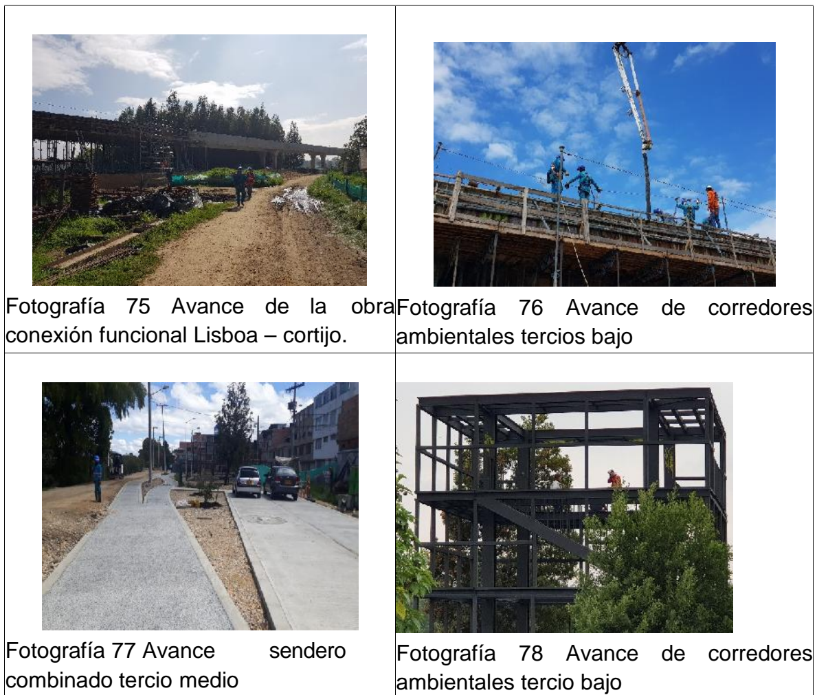
Figura 47. Fotografía 75, 76, 77 y 78; Avance de la obra, corredores ambientales y sendero combinado.
