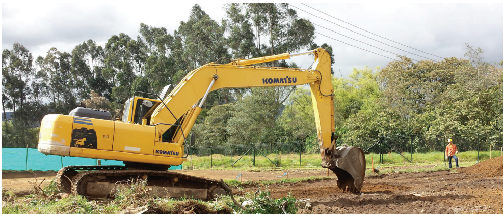
Fotografía 2. Excavación de obra en Bogotá D.C.
