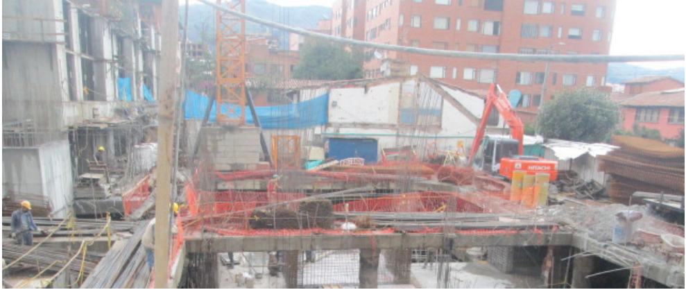
Fotografía 3. Construcción de obra en Bogotá D.C.
