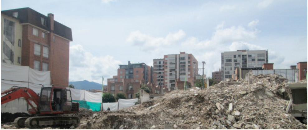
Fotografía 1. Demolición de obra en Bogotá D.C.
