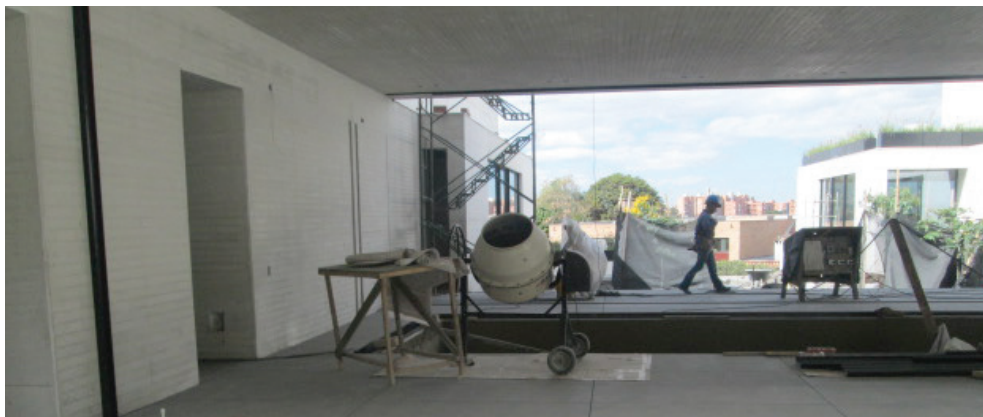
Fotografía 4. Construcción de obra en Bogotá D.C.
