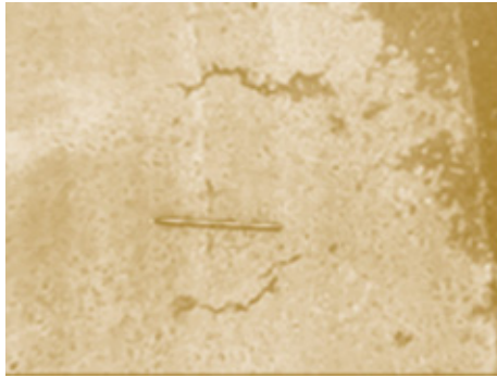
Capa asfáltica con mezcla de caucho reciclado
