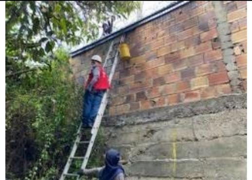
**Fotografía 14:** Instalación de cercha zona bodega 60del muro de Corabastos.
