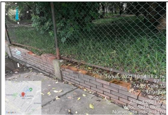
**Fotografía 7** Deterioro malla perimetral, dado que se identifican módulos completos con falta de soldadura y pintura.
