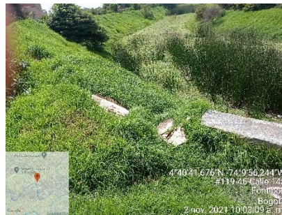
FOTOGRAFÍA 41: DISPOSICIÓN INADECUADA DE RESIDUOS SOLIDOS
