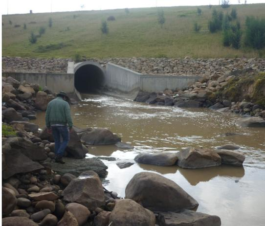
FIGURA 7.7. Descarga de fondo del embalse seco de Cantarrana
